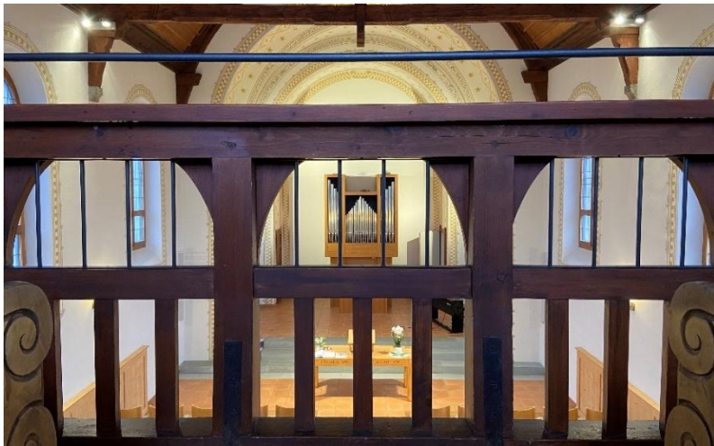
Emporenbrüstung mit verbesserter Absturzsicherheit
